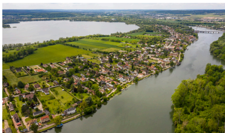
Prise de vue aérienne de la commune de Pont-de-l'Arche (Eure) - Programme Petites Villes de demain
