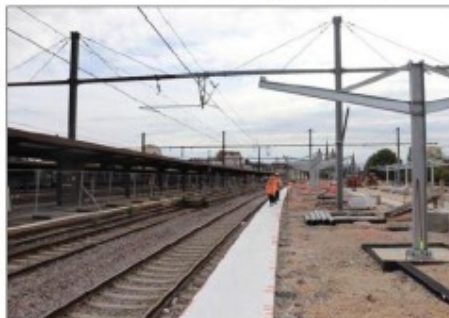
Les abris voyageurs des quais 4 et 5 sont en train d'être changés. Ils font la même longueur que les anciens (à g.), mais laisseront passer plus de lumière, car translucides. Photo LBP/R. D.
