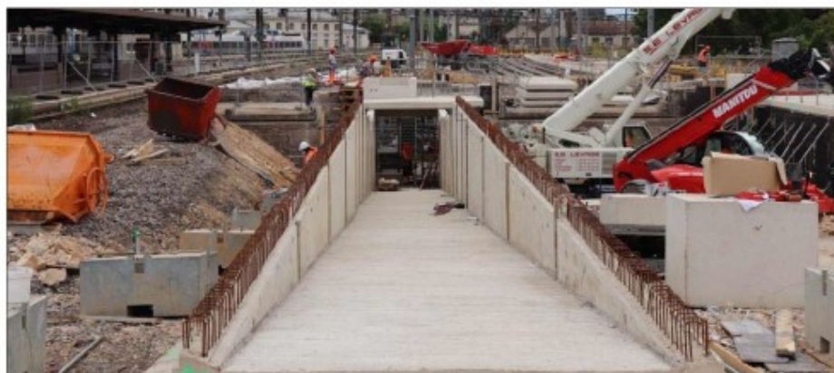
Les deux rampes d'accès des quais 4 et 5, de 46 mètres de long, ont été coulées. Elles permettront aux personnes en situation de handicap d'accéder beaucoup plus facilement aux voies qu'en empruntant les escaliers, depuis le tunnel. Un ascenseur sera également mis en place. Photo LBP/R. D.
