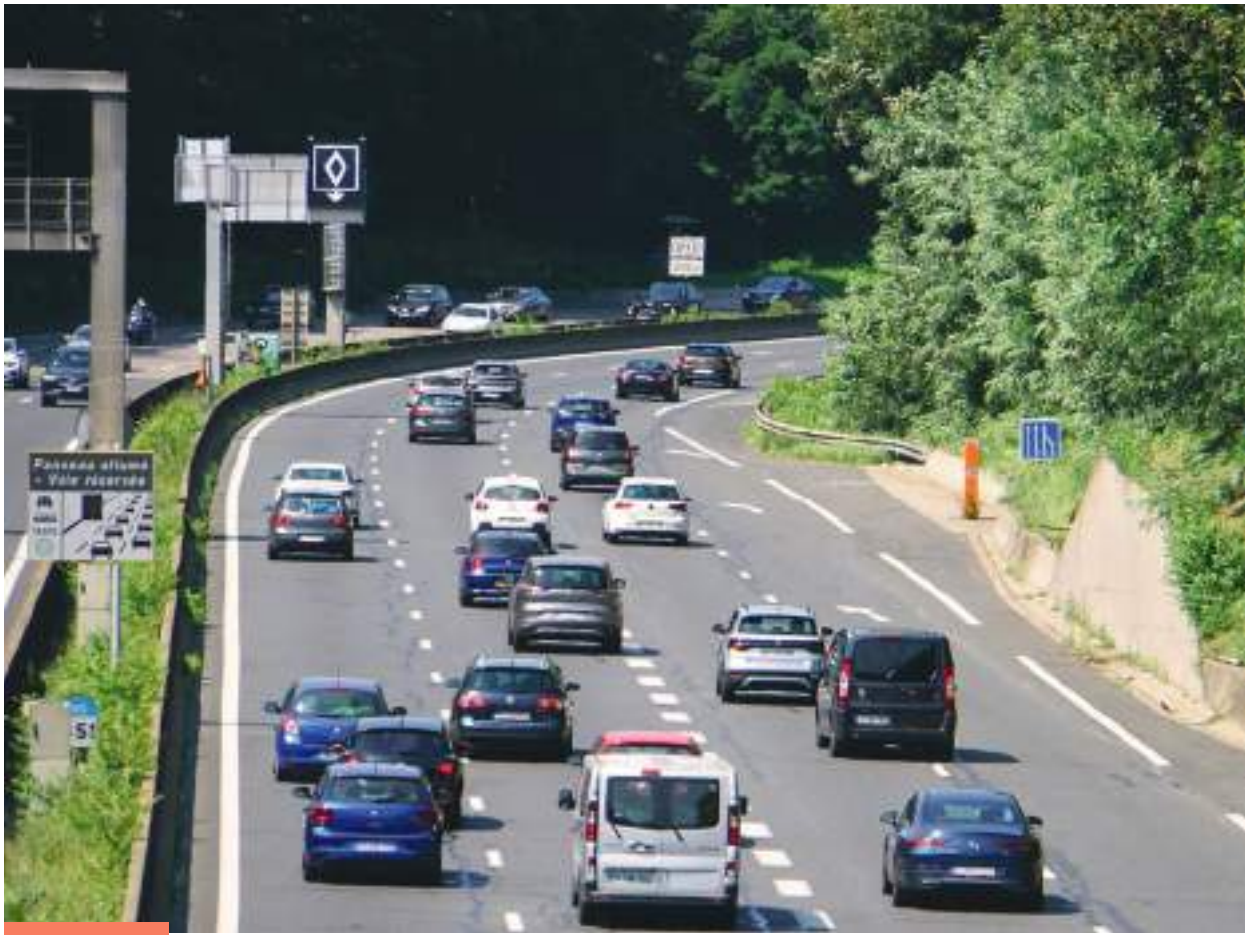
VR2+ en service sur la Métropole de Lyon. © Cerema
