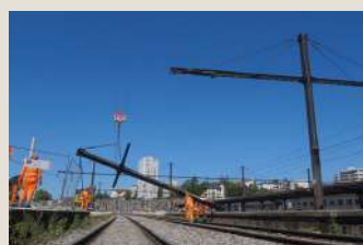
Démolition d'un poteau caténaire - été 2020
