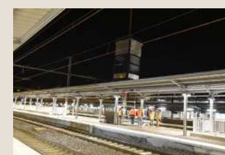
Pose de la cage d'ascenseur
