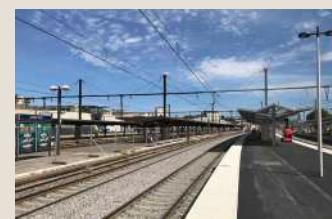
Le quai 5 terminé
