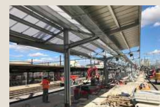
Quais 4 : préparation de la pose des enrobés de quais / Quai 5 : pose des enrobés terminée - été 2020
