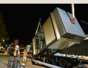
Préparation de la cage d'ascenseur avant son installation
