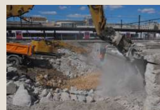
Démolition du souterrain - été 2020
