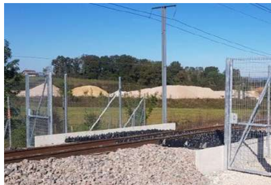
Strail Grid sur le raccordement Ouest de la LGV Rhin-Rhône
