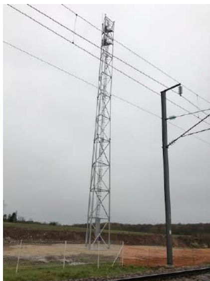
Mât GSMR installé à Arbois (39)
