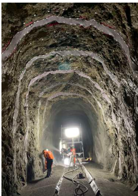
Confortement par béton projeté du tunnel de Rémonot - 07/07/2021 - Ligne des Horlogers
