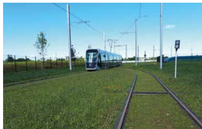
Tramway réalisé par Eurovia, à Caen
