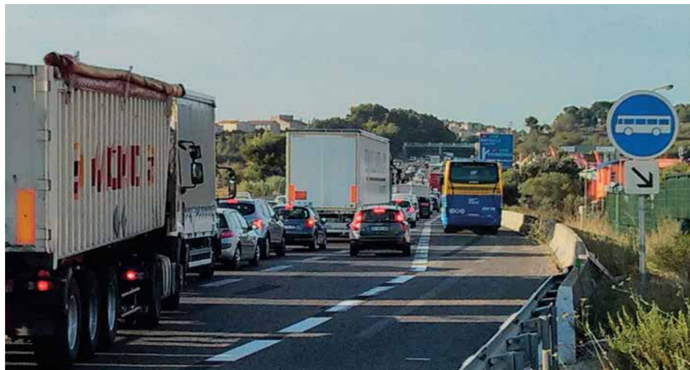
Voie réservée aux services réguliers de transport public collectif sur A51.
