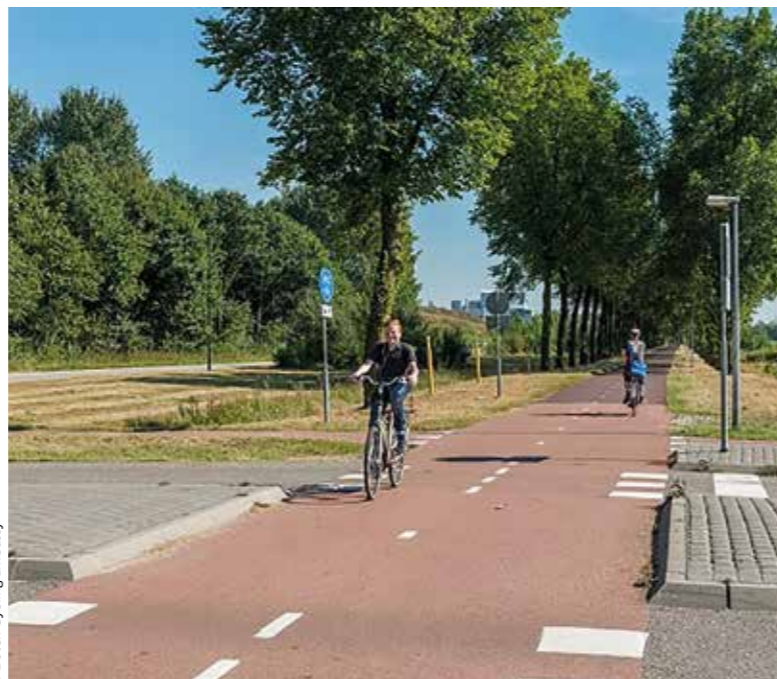
Les autoroutes cyclables interurbaines (snelfietsroutes) se sont multipliées depuis la fin des années 2000 dans les zones urbaines des Pays-Bas. Elles offrent une alternative aux embouteillages des axes d'entrée et de sortie des villes. 675 kilomètres sont prévus d'ici à 2025.
