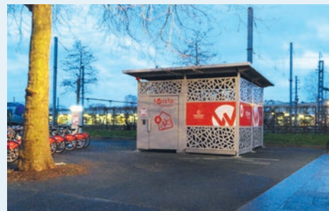
Gare de Caen (Calvados) : stationnement en consigne collective réservée aux abonné-es. Photo : Collectif Vélo Île-de-France [Marie Wehner].
