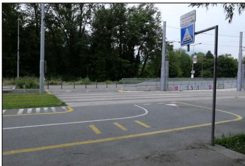
Exemple d'intersection entre un réseau cyclable à haut niveau de service et une plateforme tramway (Source : Cerema)
