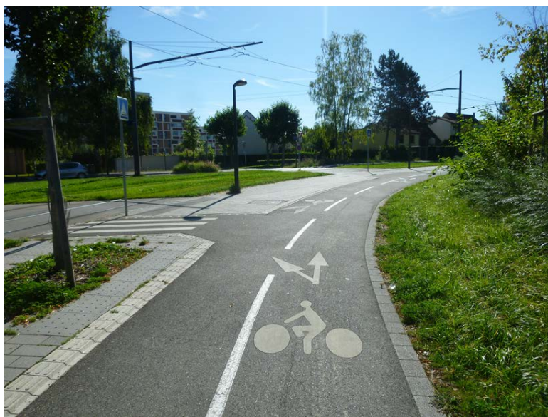
Des contrastes de matériaux viennent favoriser la lisibilité des interfaces vélos-tramway. (Source : Cerema)
