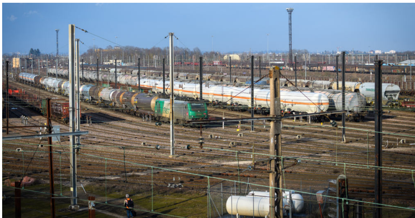
Gare de triage de Gevrey-Chambertin ©A.Bouissou/Terra
