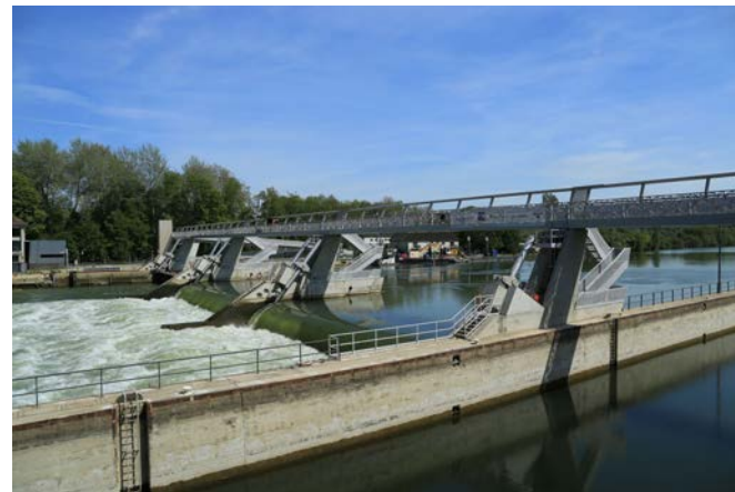
Figure 8 : Barrage de Vives-Eaux (source : VNF)
