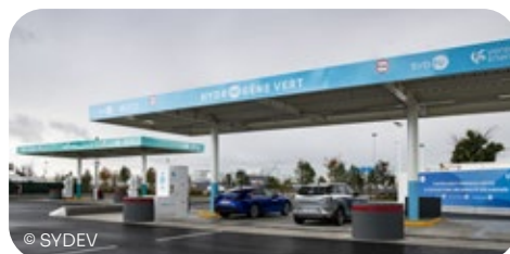
Station multi-énergies du SYDEV à La Roche-sur-Yon
