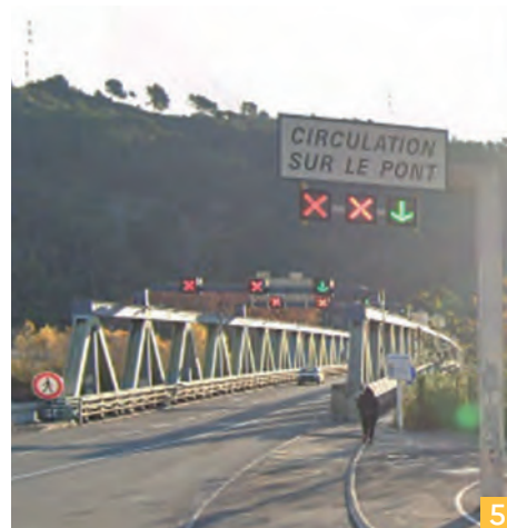
5 Extrémité Ouest, sens entrant
