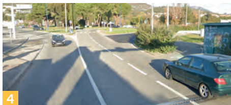
4 Extrémité Ouest, sens sortant
