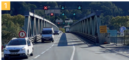
1 Activation de la voie centrale
