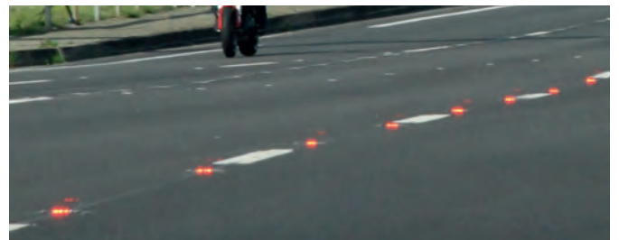
Plots lumineux pour compléter le marquage existant
