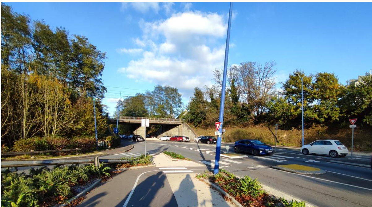
Figure 41 : Aménagements qualitatifs à l'entrée du giratoire Pompidou à Vannes
