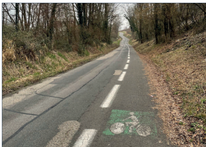
Voie hors agglomération à sens unique équipée d'un double sens cyclable
