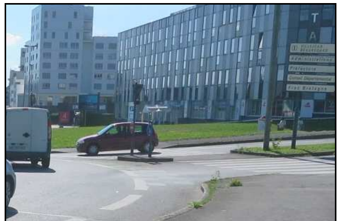
Entrée et sortie de giratoire sans îlot pour protéger les cyclistes (N137, route de Saint-Malo)
