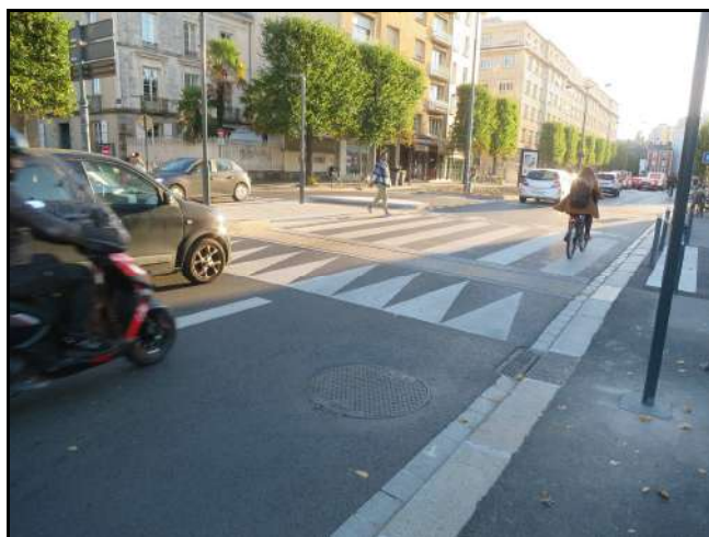
Traversée à niveau avec plateau surélevé (Rennes)
