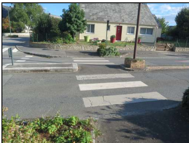
Abaissé de trottoir et îlot central (Chantepie)
