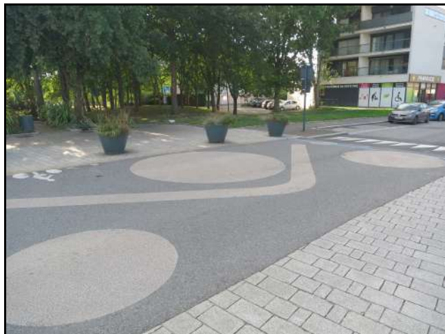
Plateau avec motifs et changement de matériau (Chantepie)
