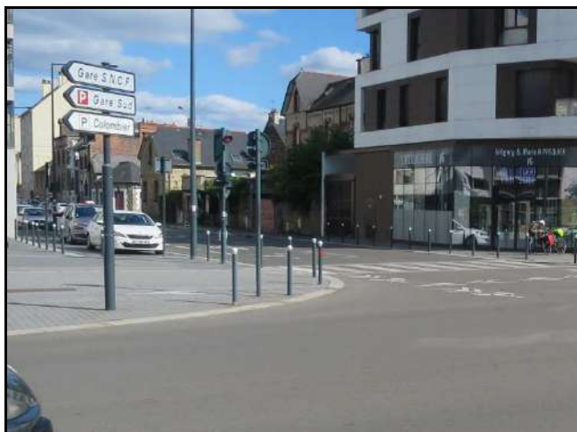
Rayon de giration réduit et potelets (Rennes)
