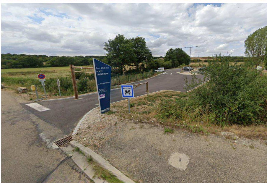
Figure 31 – Exemple de l'aire pu parc d'activité Porte du Morvan (89) panneau de covoiturage à l'entrée, barrière de limitation de hauteur, parking revêtu et éclairé, abri d'attente et mobilier
